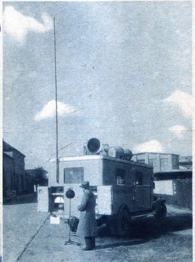
Die Kreisleitung der NSDAP Stettin hat sich diesen schönen Wagen zugelegt, der ausgerüstet ist mit allen Erfordernissen hochwertigster Verstärkung, mit Schneideapparaturen und Großlautsprechern und vor allem, wie man auf diesem Bild sieht, mit einer großen, außen aufsteckbaren Antenne. (Werkphoto Telefunken.)
